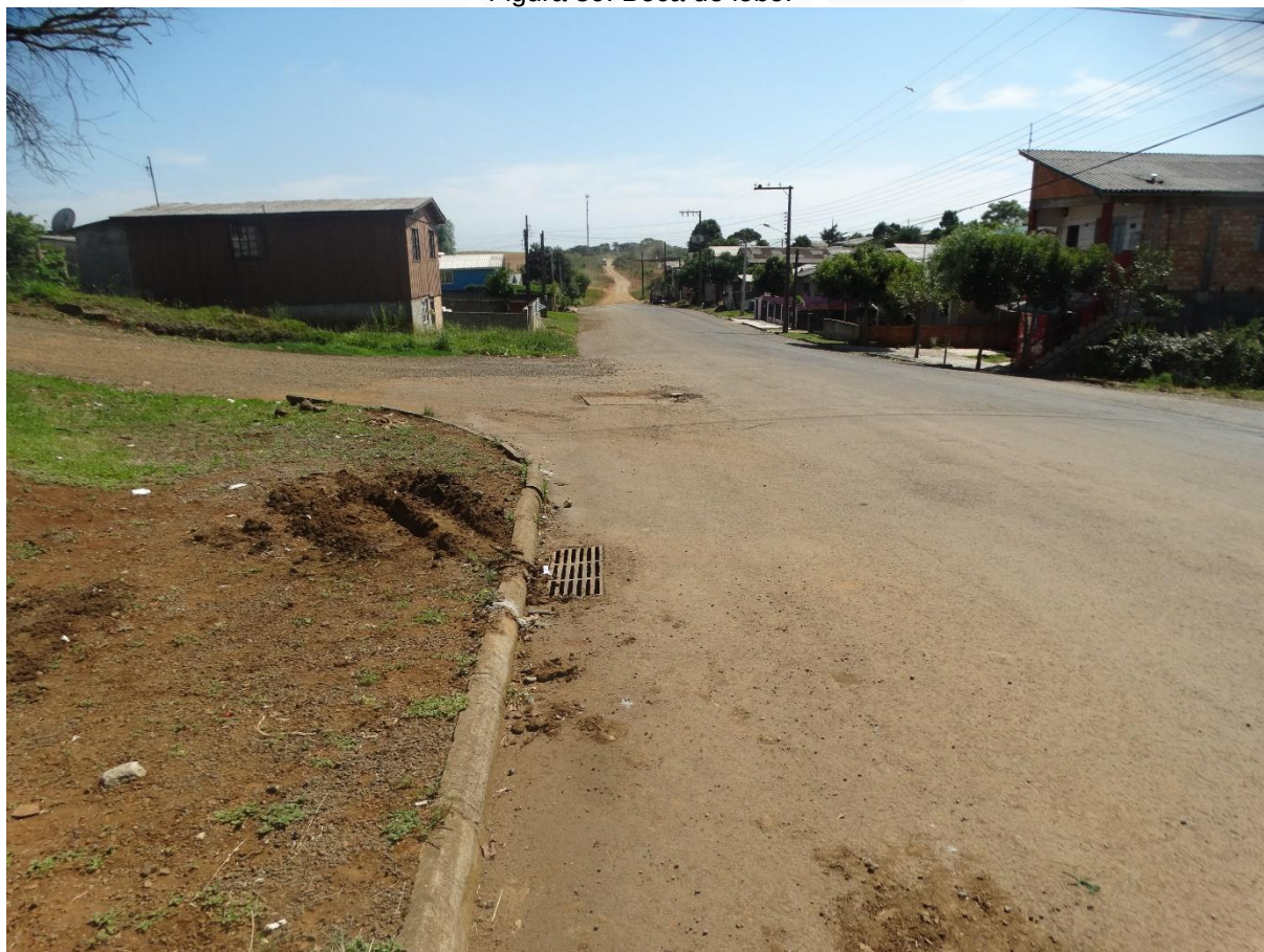
Figura 39: Boca de lobo.
